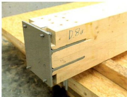
Da musste beim Zusammenbau in der Werkstatt gut aufgepasst werden, damit alle notwendigen Bolzen vor dem Schlagen der Stabdübel schon eingesteckt werden und alle übrigen Bolzenlöcher freigehalten wurden.
