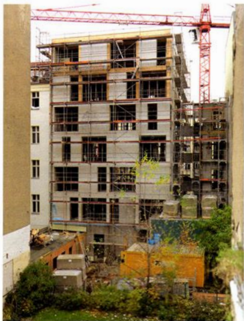
Die Attika des Flachdaches ist gerichtet, das Ziel erreicht, hier Blick von hinten, links unten die Kellersatzräume, rechts der Treppenhaustrum und die „Brücken“ zum Wohnblock.
