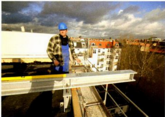
Der Stahlträger zur Abhängung der Balkone wurde über der Flachdachabdichtung im Freien angeordnet, eine sehr einfache, konstruktive Lösung, die Wärmebrückenprobleme umgeht und jederzeit kontrollierbar ist.
